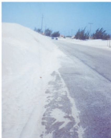
Figura 4 Movimentação eólica dos sedimentos sobre a estrada de acesso Cabo Frio – Arraial do Cabo
