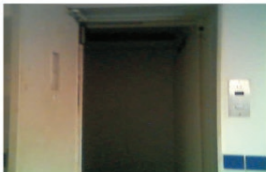
Figura 3 Elevador do Bloco A Fonte: SILVA, 2007
