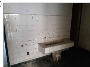
8 VISÃO GERAL DO BANHEIRO AMBIENTE SEM FORRO E COM LUMINÁRIAS INSTALADAS. PISO EM GRANILITE PRETO DESGASTADO E PAREDES COM TRECHOS COM DESCOLAMENTO DA PINTURA E FURROS NA PARTE SUPERIOR.
