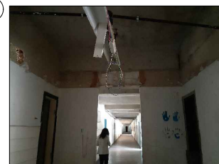
7 O PISO EM GRANILITE PRETO SE ENCONTRA COM MACHAS PROVENIENTES DA INFILTRAÇÃO DO TETO.
