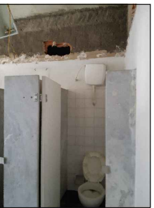
10 FOTO DOS LAVATÓRIOS O BANHEIRO APRESENTA 3 PONTOS DE LAVATÓRIO. EXISTEM 3 LAVATÓRIOS SEM COLUNA EM LOUÇA BRANCA INSTALADOS, SEM TORNEIRAS. O AMBIENTE APRESENTA 2 FURROS NA PARTE SUPERIOR DAS PAREDES COMO MOSTRADO NA FOTO.
