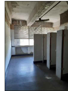
9 VISÃO DA CABINE SANITÁRIA CABINES COM DIVISÓRIAS EM MÁRMORE BRANCO E PORTAS COM LAMINADO NA COR BRANCA. AS CABINES APRESENTAM DESGASTE E MANCHAS EM ALGUNS PONTOS E AS PORTAS SE ENCONTRAM EMPENADAS E SEM FECHO.
