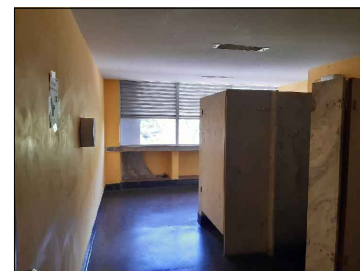
7 VISÃO GERAL DO BANHEIRO AMBIENTE COM FORRO E COM LUMINÁRIAS INSTALADAS. PISO EM GRANILITE PRETO DESGASTADO E PAREDES COM TRECHOS COM DESCOLAMENTO DA PINTURA E DIVISÓRIAS E PORTAS COM MANCHAS E PONTOS TRINCADOS.
