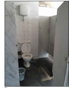
3 VISÃO DA CABINE SANITÁRIA AMPLIADA NESSE BANHEIRO HOVE A AMPLIAÇÃO DA CABINE SANITÁRIA PARA MELHORAR O ACESSO.
