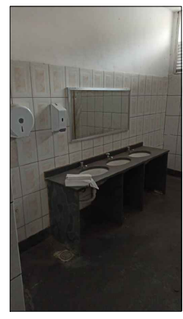
FOTO DA PIA BANCADA DE MÁRMORE CINZA E CUBAS EM LOUÇA BRANCA COM TORNEIRAS E ACESSÓRIOS INSTALADOS. PAREDES REVESTIDAS E PISO COM DESGASTE APARENTE.
