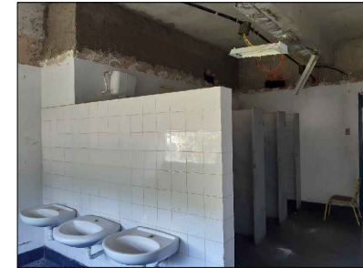
9 VISÃO DA CABINE SANITÁRIA CABINES COM DIVISÓRIAS EM MÁRMORE BRANCO E PORTAS COM LAMINADO NA COR BRANCA. AS CABINES APRESENTAM DESGASTE E MANCHAS EM ALGUNS PONTOS E AS PORTAS SE ENCONTRAM EMPENADAS E SEM FECHO.
