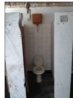
3 FOTO DAS CABINES SANITÁRIAS
